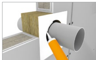
Verschließen des Ringspalts mit Astomastik Spachtel
