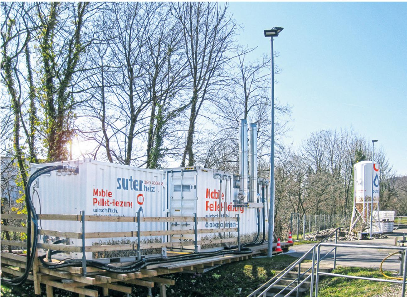
Die mobile Heizanlage in der ARA Langmatt in Wildegg mit dem Hydraulikmodul im 10-Fuss-Container links und der Heizzentrale im 20-Fuss-Container rechts. Im Hintergrund steht das Pelletsilo. (Bilder: ZVG)
