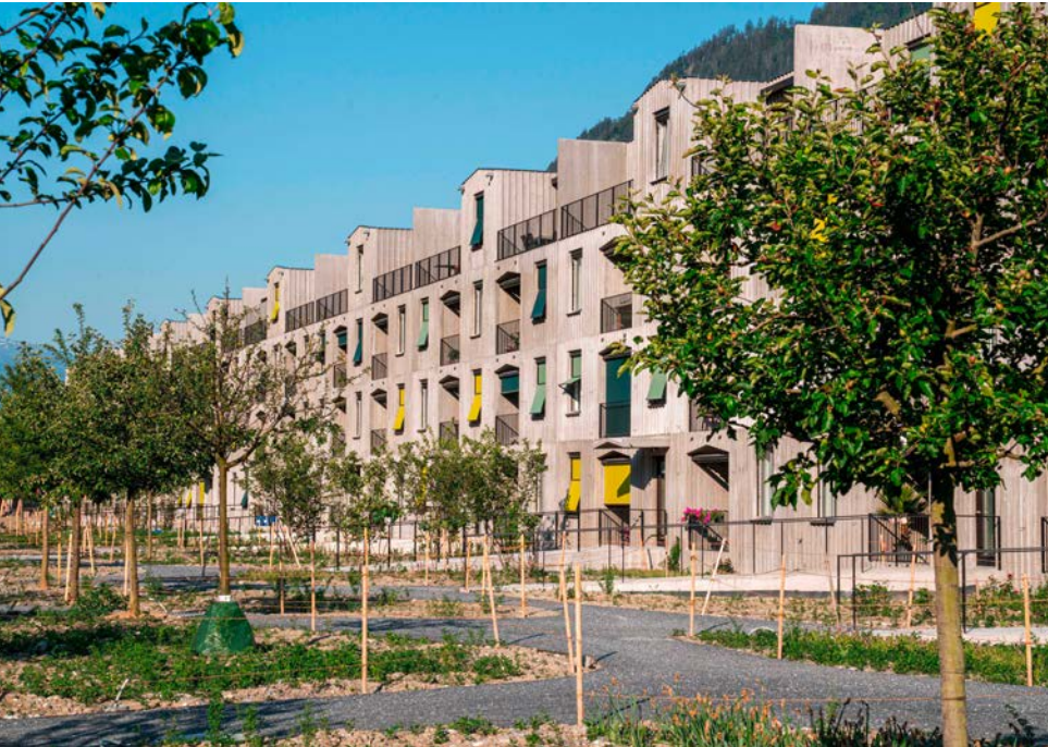
Die neue Wohnsiedlung «Vier Jahreszeiten» in Chur, wurde während der Bauzeit mit mobilen Pelletheizungen von Suter Entfeuchtungstechnik ökologisch entfeuchtet und beheizt. (Bild: Bürgergemeinde Chur)
