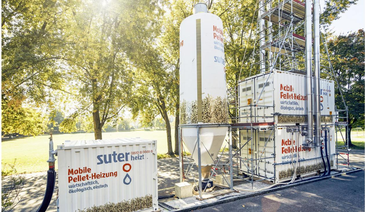
Limeco Wärmeverbund-Versorgung mittels pelletbefeuerten 900-kW-Heisswasserzentrale in Dietikon ZH.
